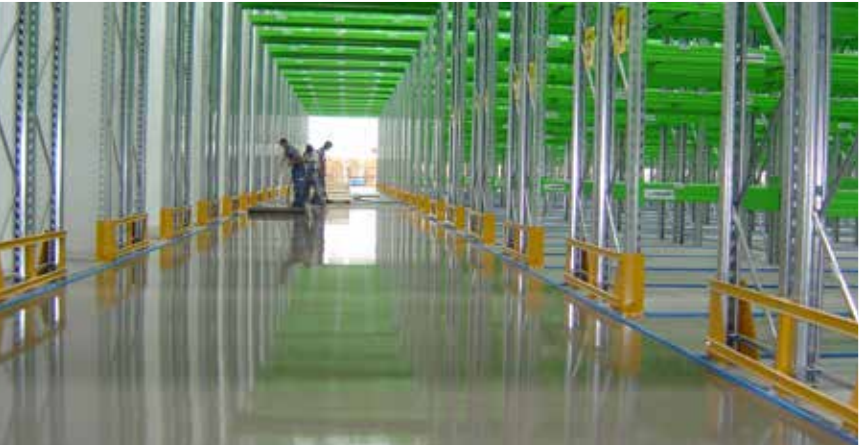
Magazzino a grandi altezze
