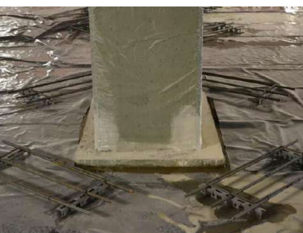
Posa in opera di barriera al vapore costituita da telo in polietilene da 200 micron
