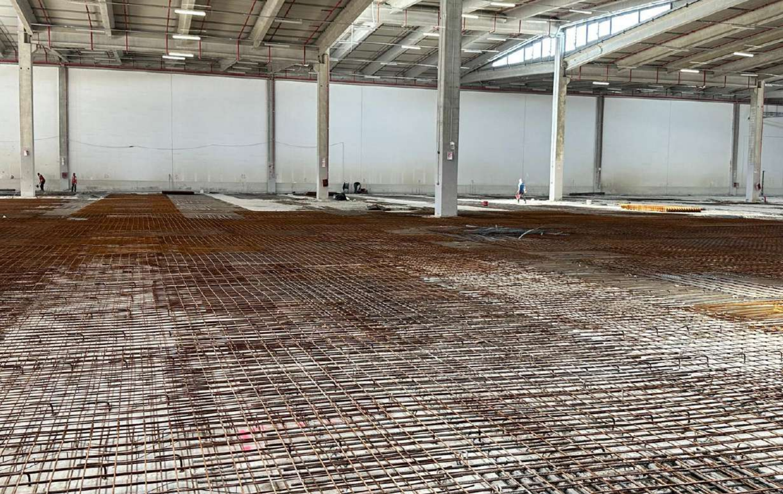
Posizionamento doppia armatura
