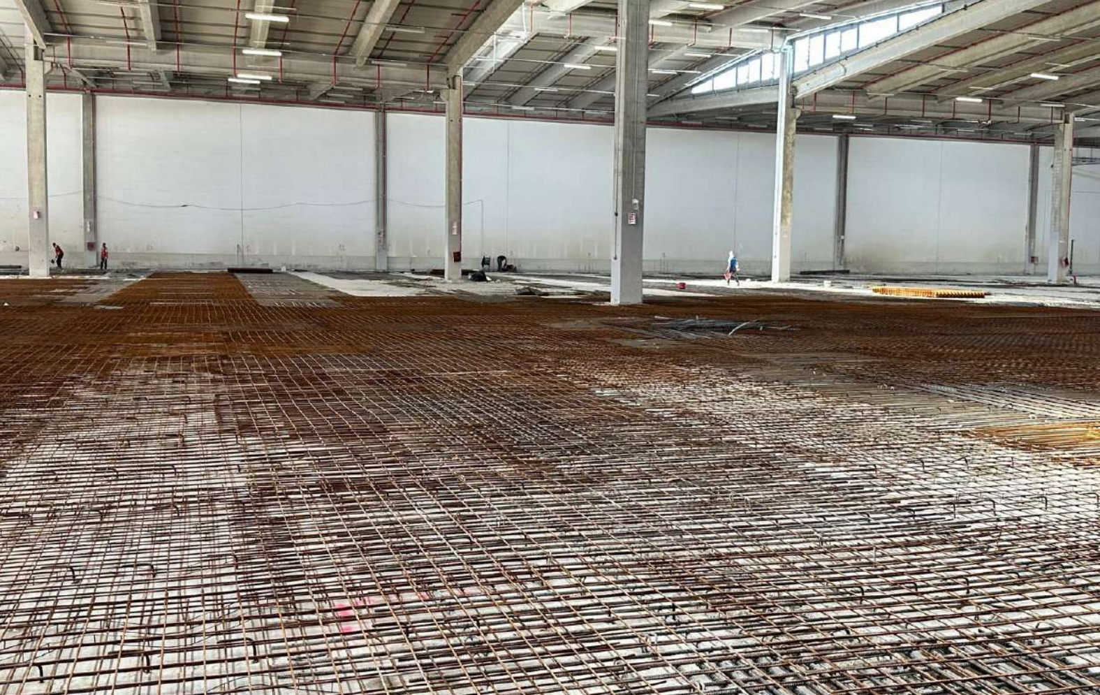
Posizionamento doppia armatura
