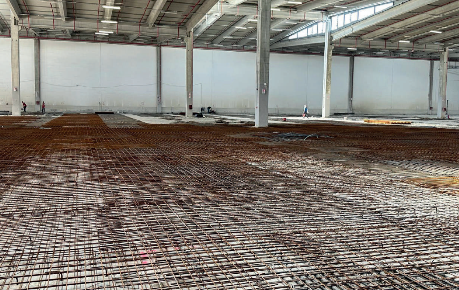
Posizionamento doppia armatura
