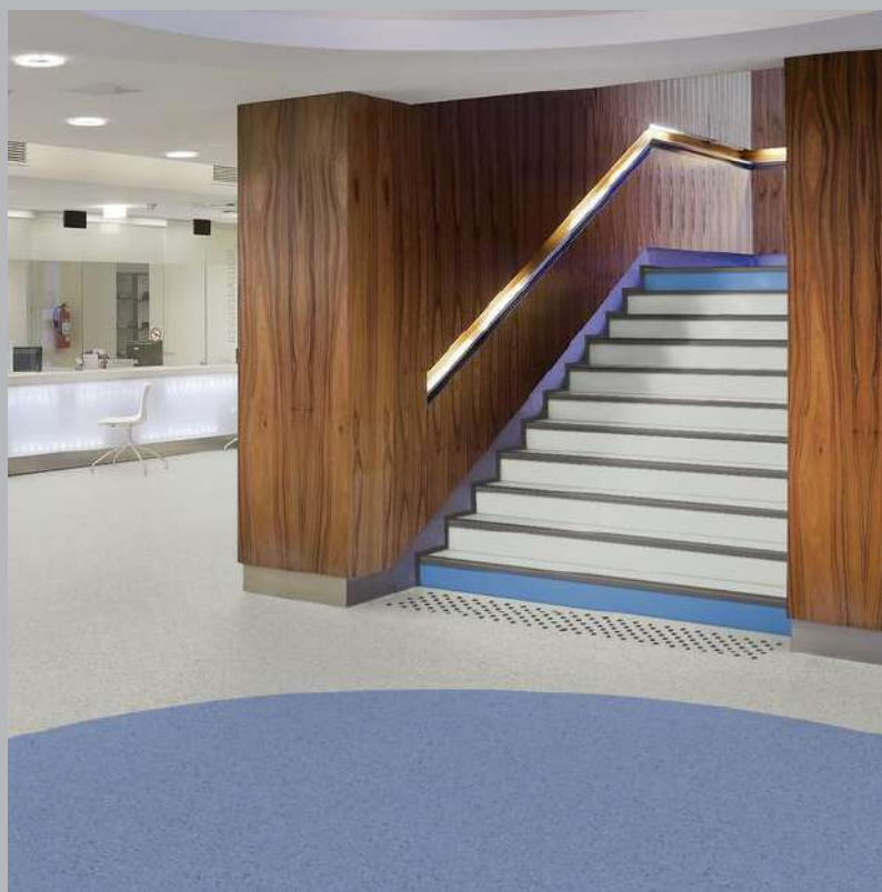
Scale in PVC con profili in alluminio e percorso tattile ipovedenti
