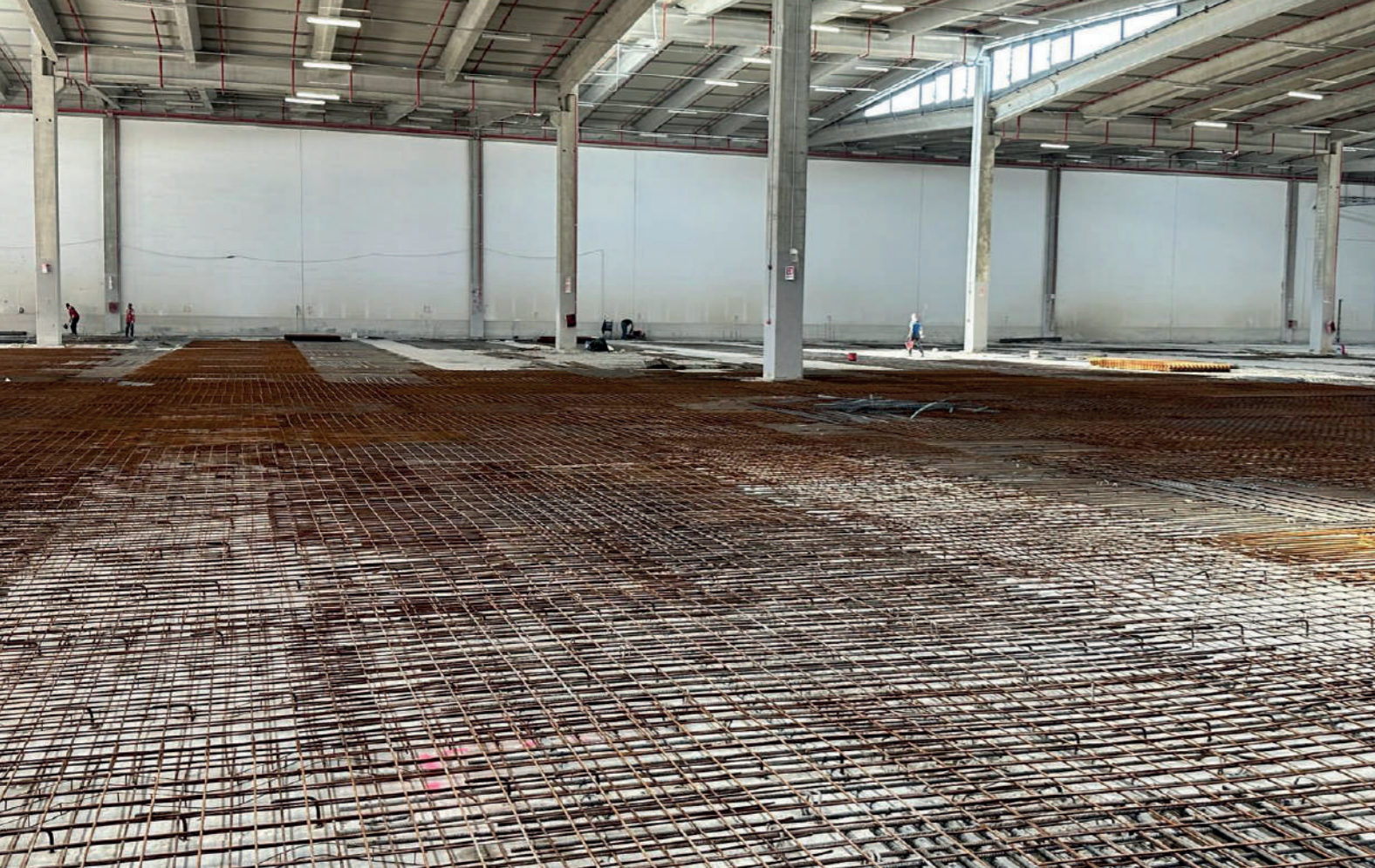
Posizionamento doppia armatura
