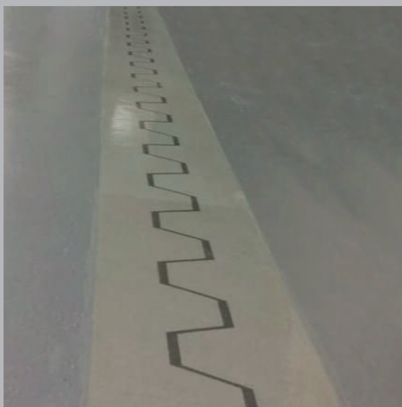
Smart Joint® su pavimento in resina finito
